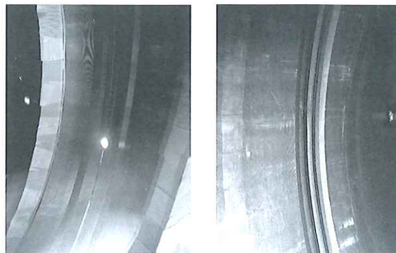
写真3 溶接中の裏波溶融状況（左）と初層溶接後の裏波外観
